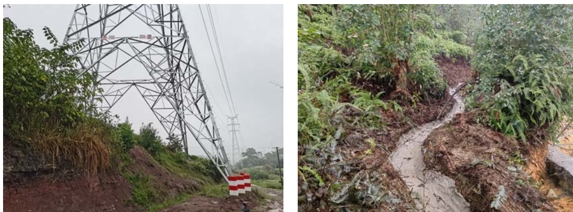
图 8-10 塔基下方挡土墙、排水沟建设情况
