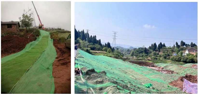
施工便道 施工临时占地 图 6-5 施工期临时占地铺垫物铺设情况
