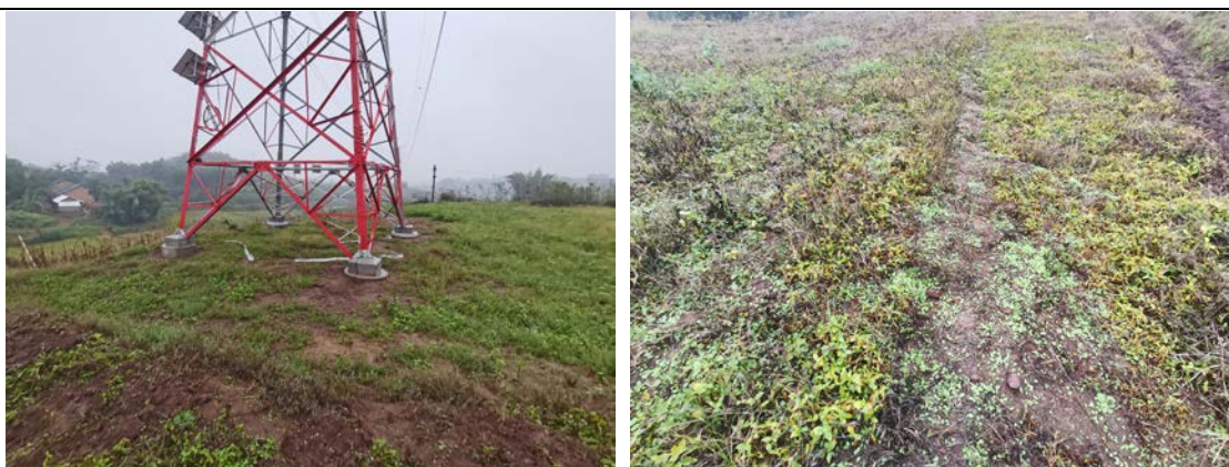
图 8-9 输电线路塔基下方和施工便道播撒草籽生长情况
