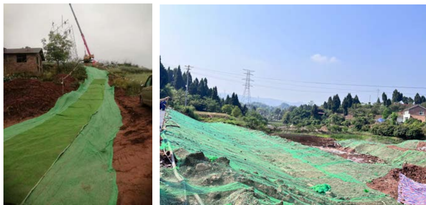
图 8-3 施工便道、施工临时占地防雨布覆盖
